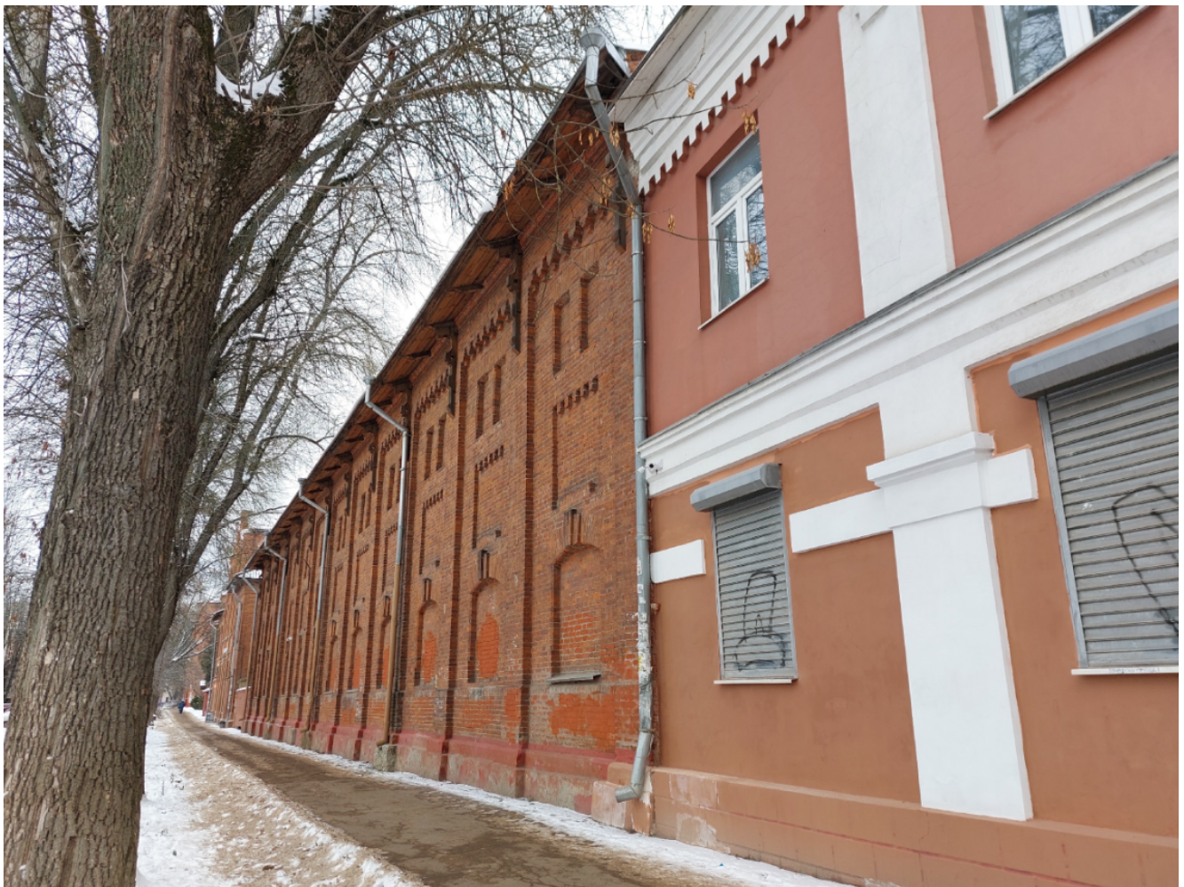
ОКН "Здание цистерн". Вид на стыковку с ОКН "Сторожка с приемным покоем" с юга.
