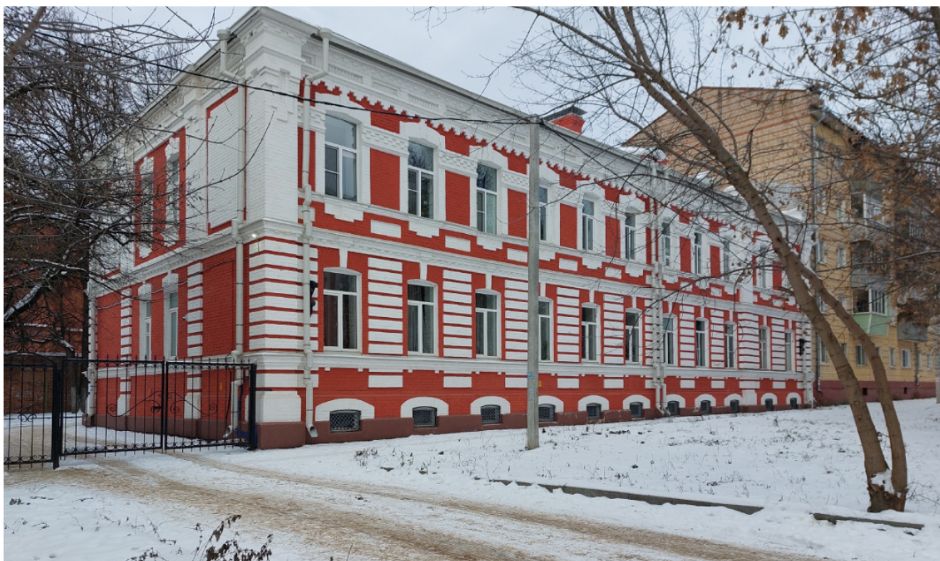
ОКН "Жилой дом". Вид на торцевой и главный фасад с юго-востока
