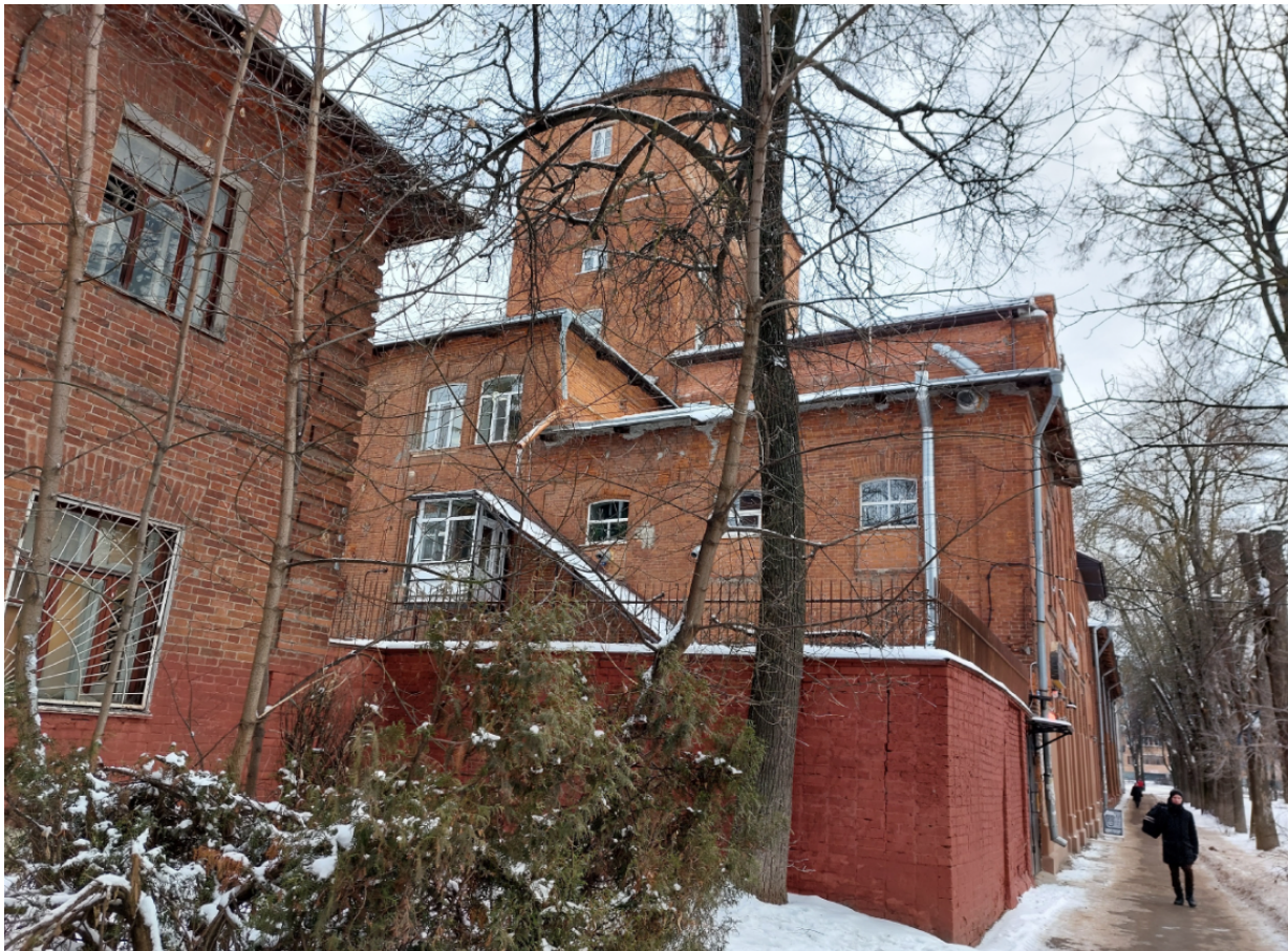
ОКН "Здание цистерн". Вид на торцевой фасад с запада
