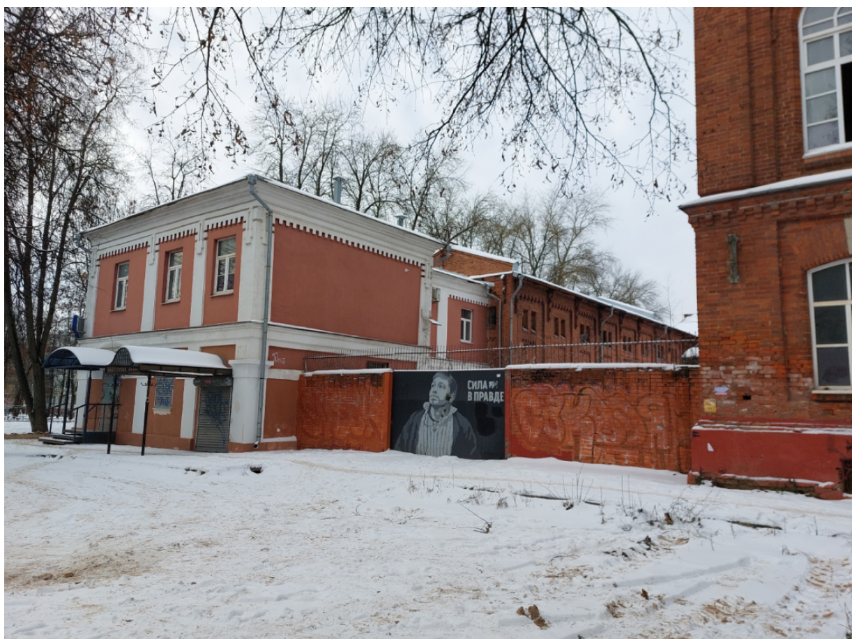
ОКН регионального значения, памятник архитектуры "Сторожка с приемным покоем" с востока (г. Калуга, ул. Билибина, д.33, стр.2)
