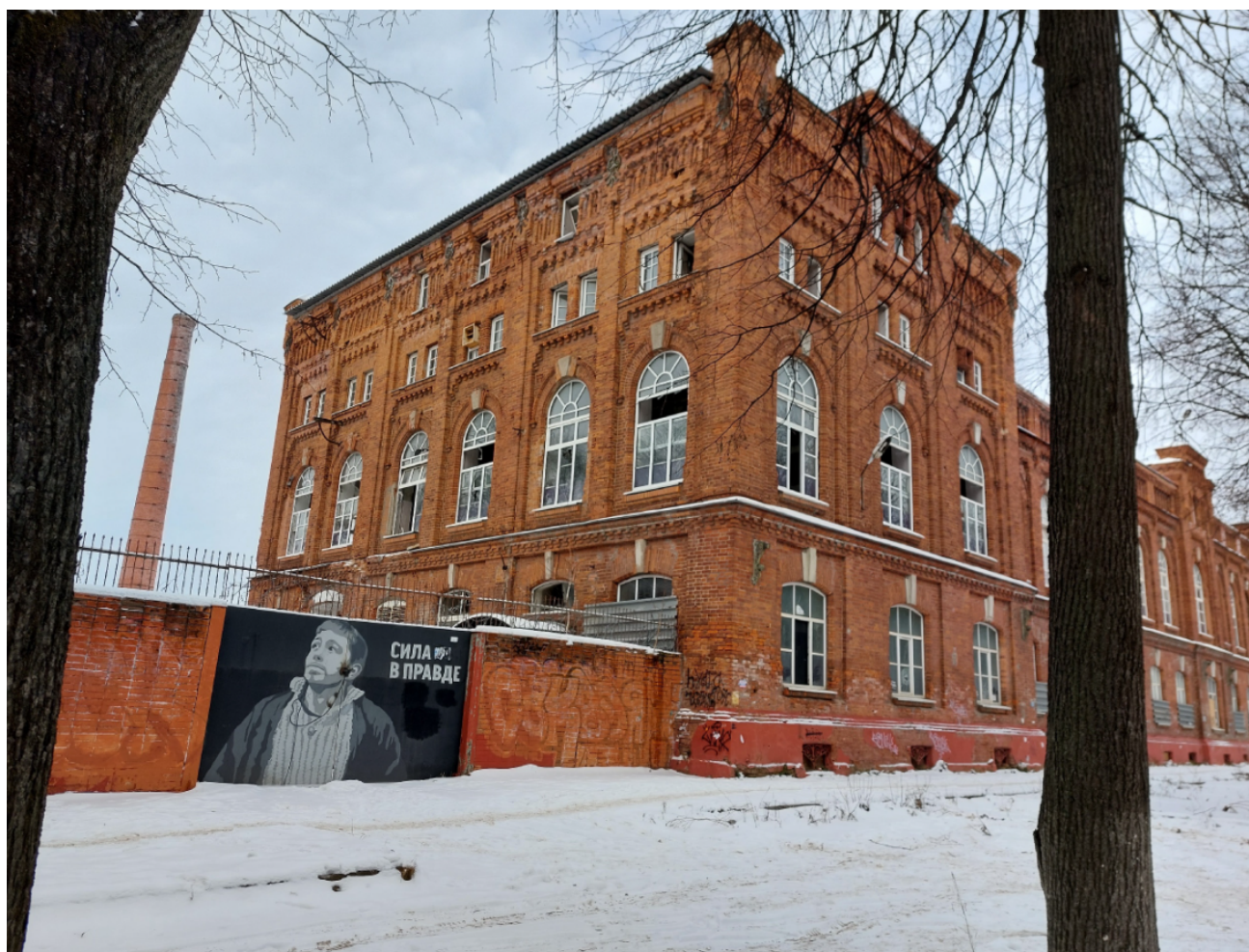
ОКН "Здание склада". Вид на торцевой и главный фасад с запада
