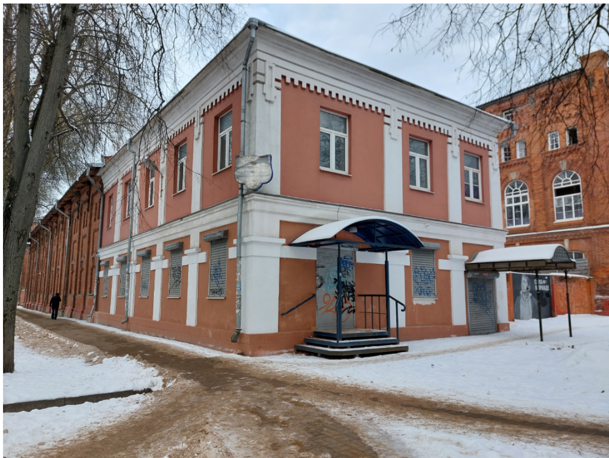
ОКН регионального значения, памятник архитектуры "Сторожка с приемным покоем" с юга (г. Калуга, ул. Билибина, д.33, стр.2)
