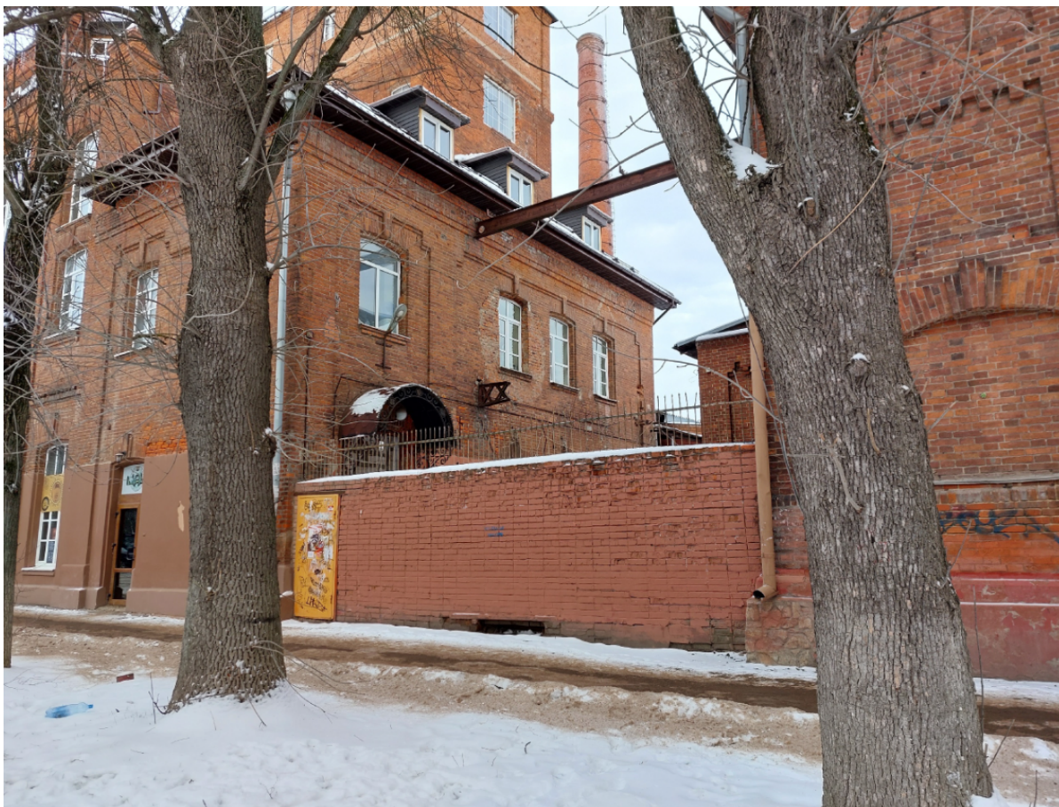
ОКН "Здание цехов ректификации спирта, водоочистки и котельной". Вид на торцевой фасад с юга-востока
