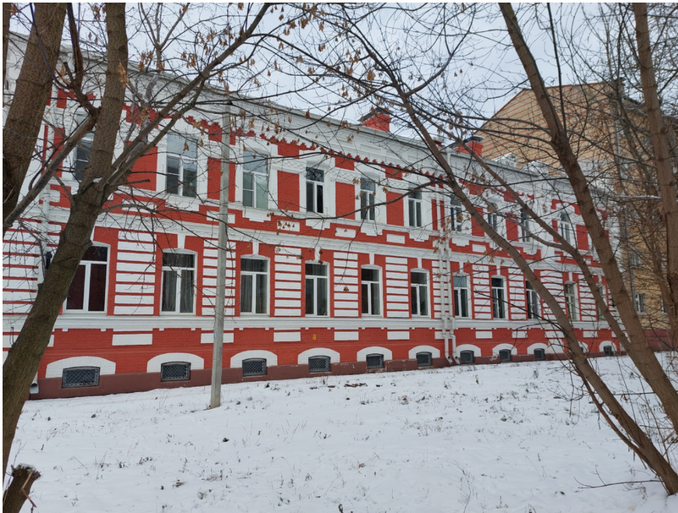
ОКН "Жилой дом". Вид на главный фасад с востока
