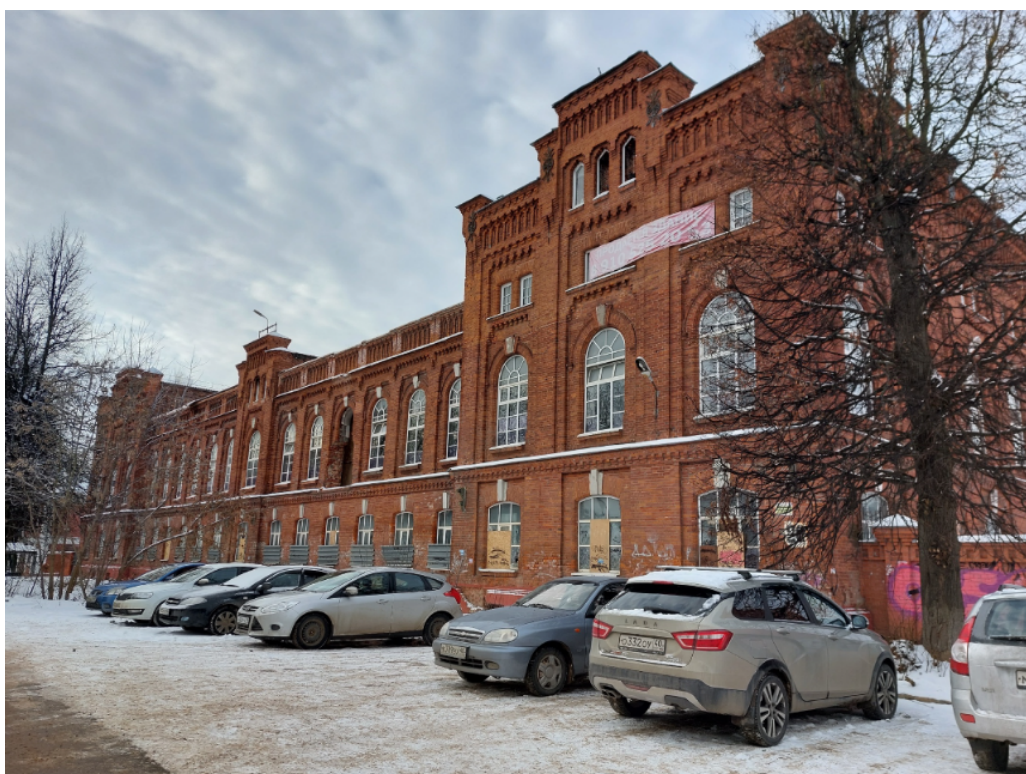
ОКН "Здание склада". Вид на главный фасад с востока
