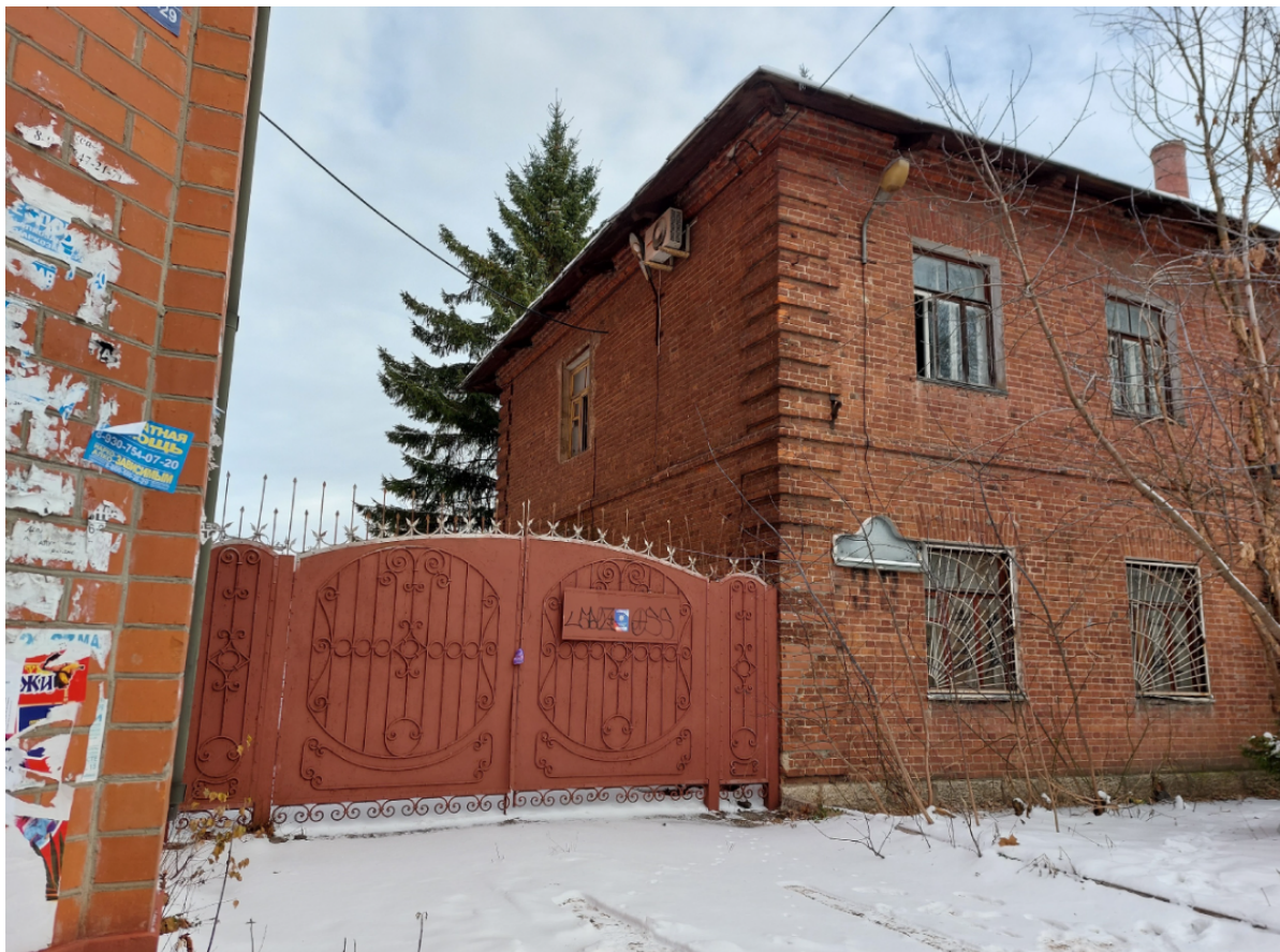
ОКН "Здание заводоуправления". Вид на торцевой фасад с юга-запада
